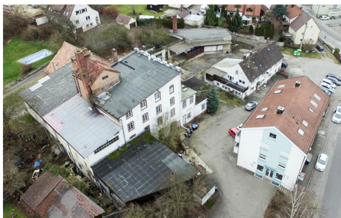
Luftbild 2018 vor dem Abbruch (Quelle: Sen & Kramer)
