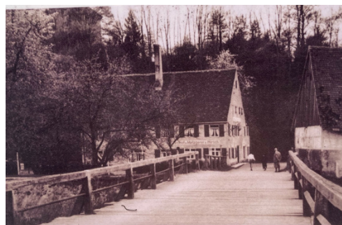
Brücke mit Gasthaus u. Metzgerei z. Hirsch
